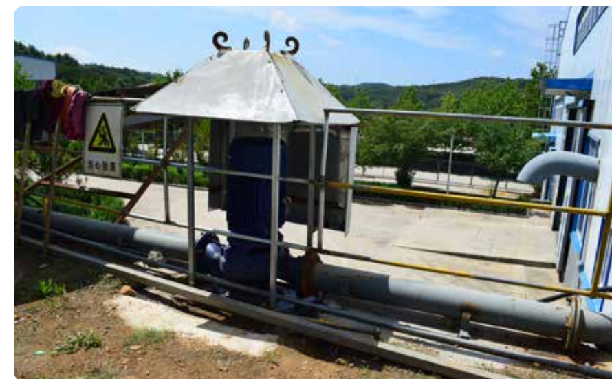
在选矿厂回水管路安装增压泵
