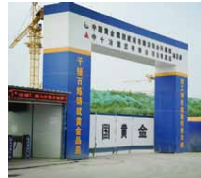
天津宝坻项目工地。
