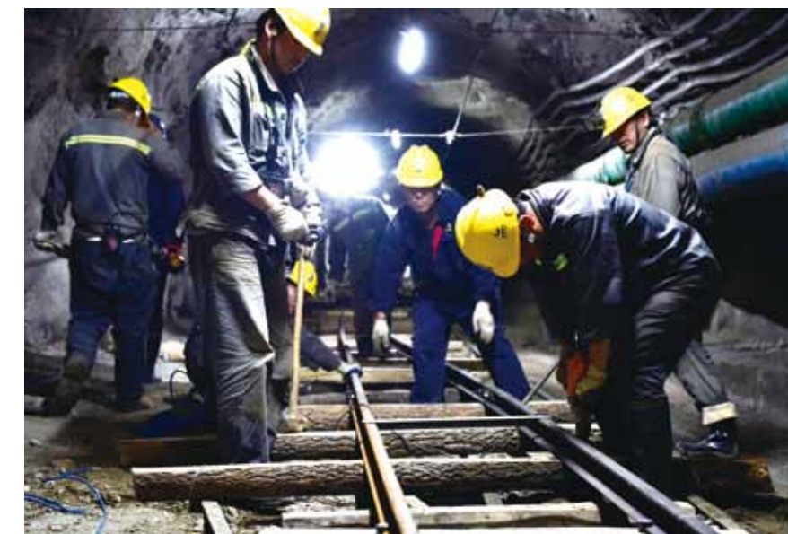
为适应箕斗运输铺设道轨。
